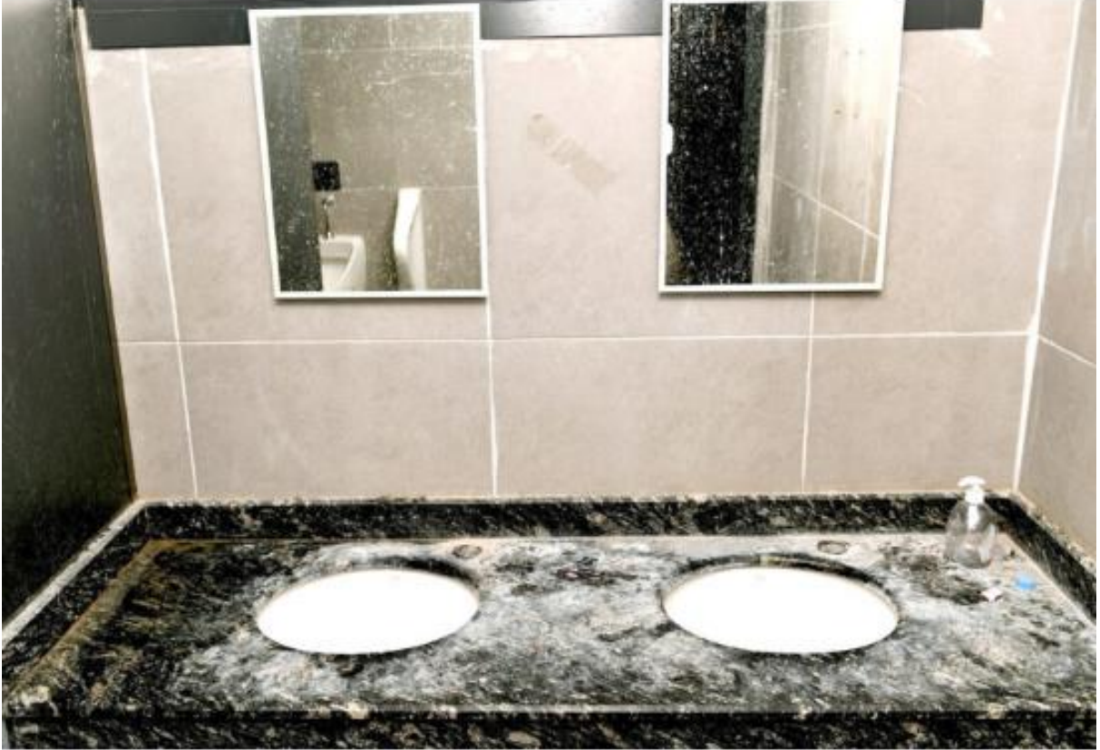
MERSİN'DE ÇİFTLİKKÖY MEZARLIĞINDAN BULUNAN TUVALETLERİN KAPILARI VE İÇ TEFRIŞAT MALZEMELERİ ÇALINDI. (HABERMERSİN-HHA) Mersin'de Çiftlikköy Mezarlığı'ndan bulunan tuvaletlerin kapıları ve iç tefrişat malzemeleri çalındı.
